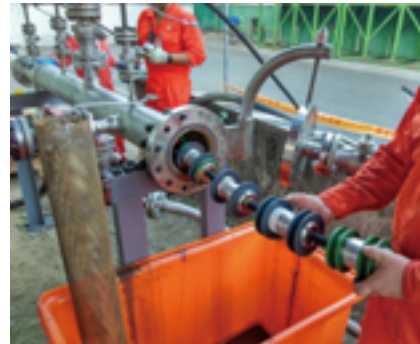
地下管線超音波檢測儀器
