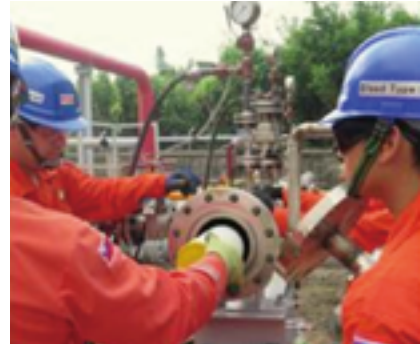
智慧型通管器檢測過程
